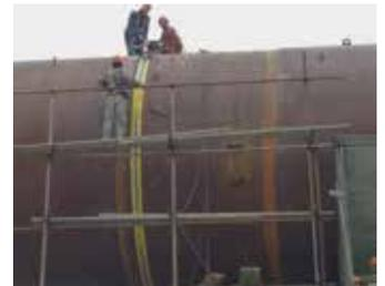
Die hier abgebildeten Gurte (Abb. links) werden um das Rohr gelegt und mit der Klammer (Abb. mitte) verspannt. Dank dieses einfachen Systems können alle Rohrdurchmesser abgedeckt werden. Die Gurte sind so ausgelegt, dass diese auch untereinander kombiniert werden können. So lassen sich dann auch größere Durchmesser bearbeiten.
